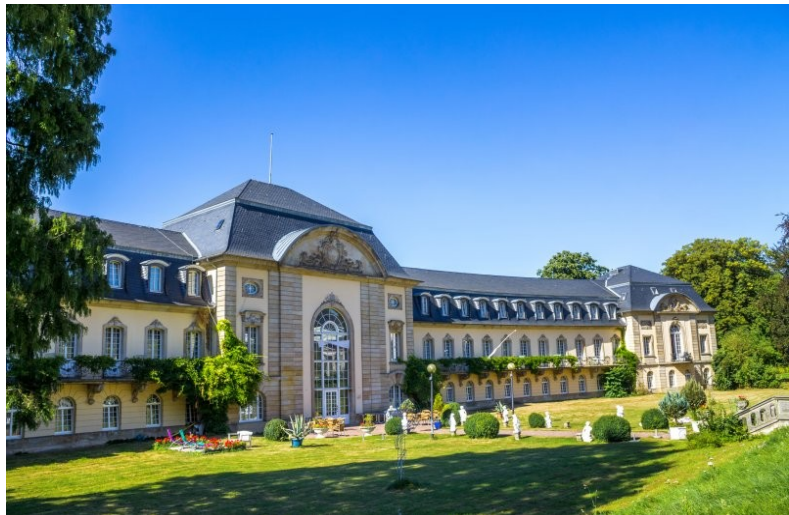
Das ehemalige Schwefelbadehaus im Kurpark Bad Nenndorf und der benachbarte Sonnengarten begrüßen die Besucher der Landesgartenschau ganz im Westen des Geländes, das so groß ist wie 45 Fußballfelder.
